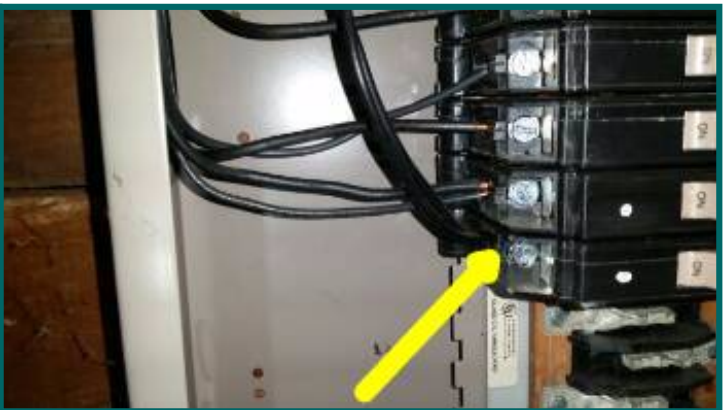
double tapped circuit.
