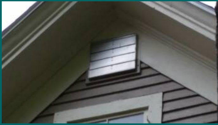
attic fan vent termination
