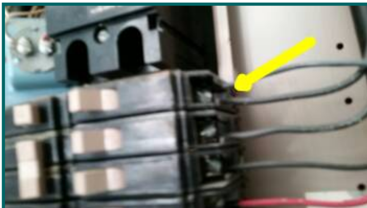
double tapped circuit.
